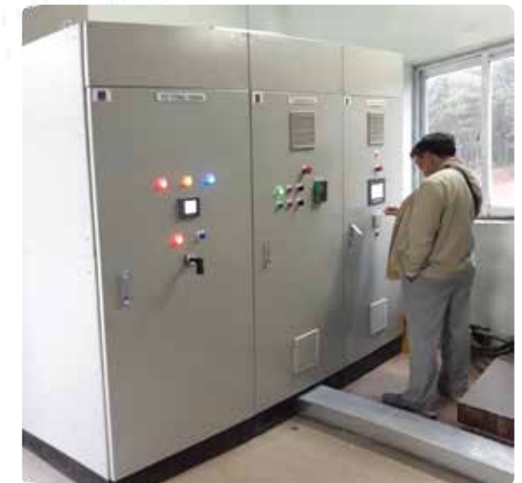
Dự án cung cấp nước nhà máy Samsung Thái Nguyên
